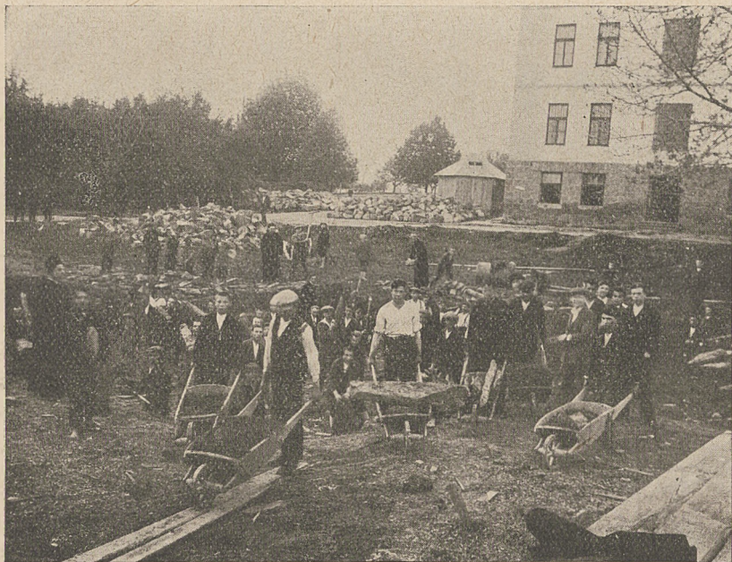
NASI PRZY BUDOWIE.
