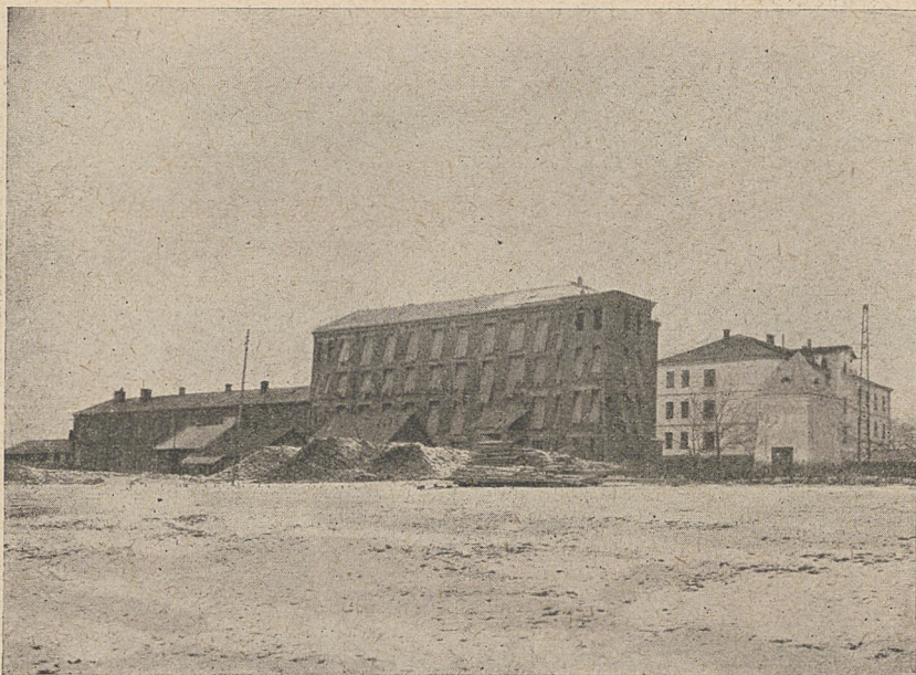
Obecny stan budowy.
