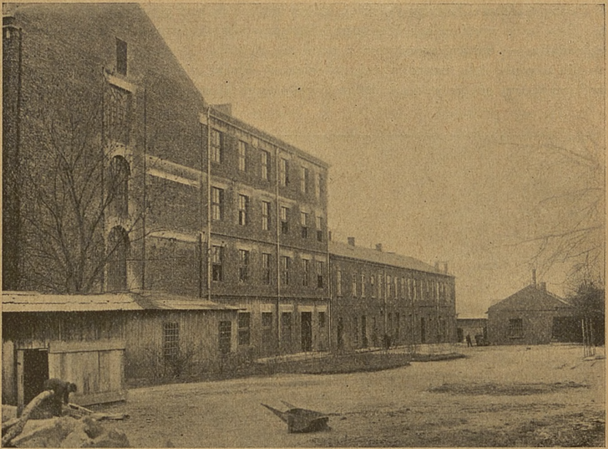
OGÓLNY WIDOK BUDYNKÓW ZAKŁADOWYCH (dom warsztatowy i szkolny).
