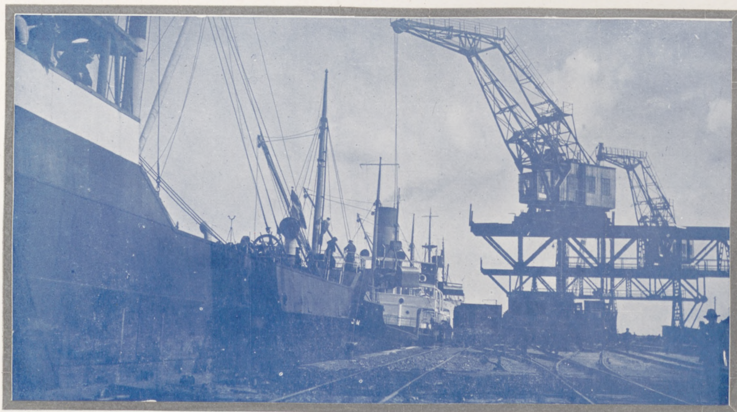
Port Gdynia. Nowe urządzenia przeladunkowe firmy „Polskarob“.
