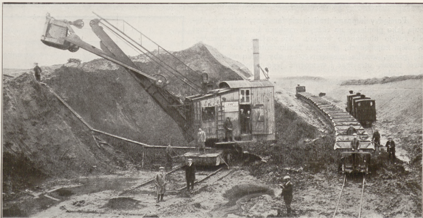
Z budowy kolei Bydgoszcz — Gdynia.
