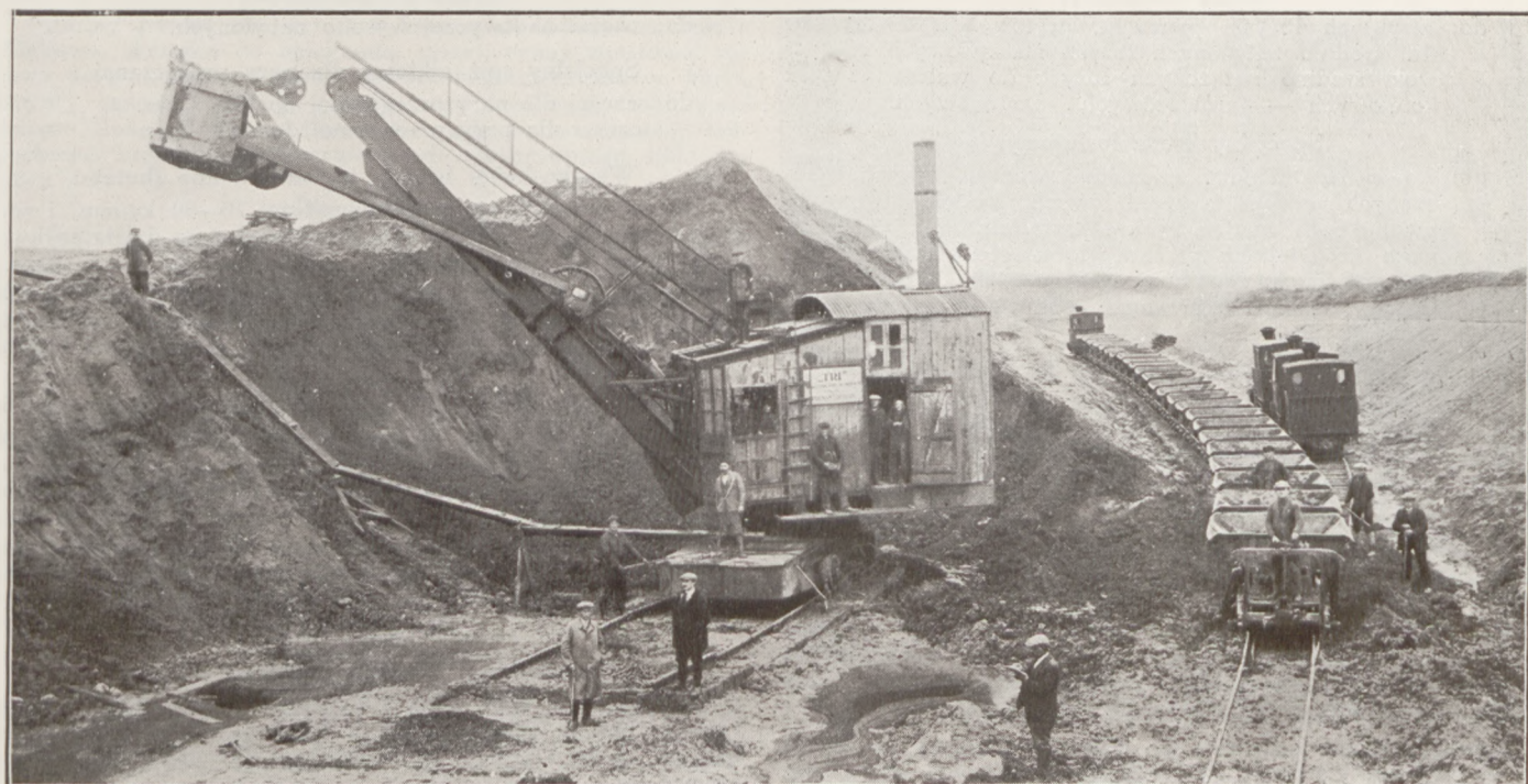
Z budowy kolei Bydgoszcz — Gdynia.
