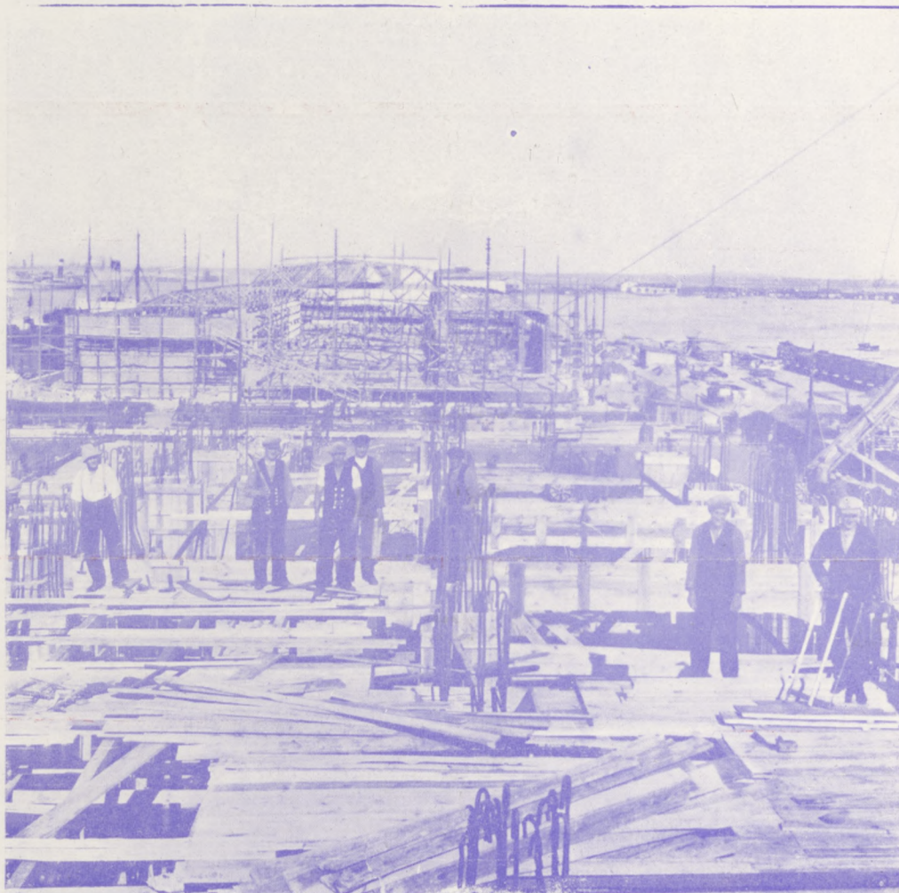
Budowa chłodni eksportowej w Gdyni
