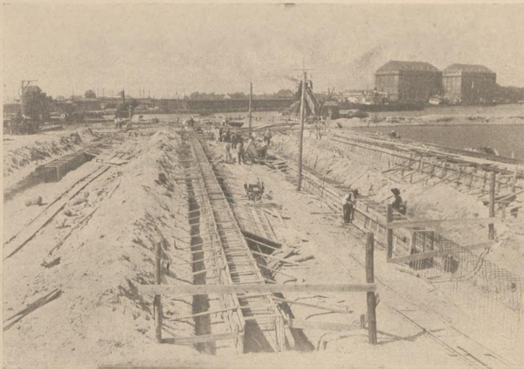
Z budowy nowego basenu w porcie gdańskim. Zakładanie fundamentów pod krany portowe.
