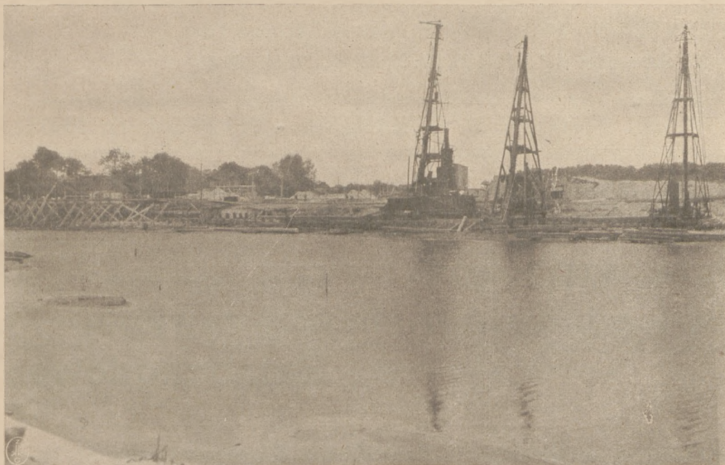
Z budowy nowego basenu w porcie gdańskim. Roboty katarowe.
