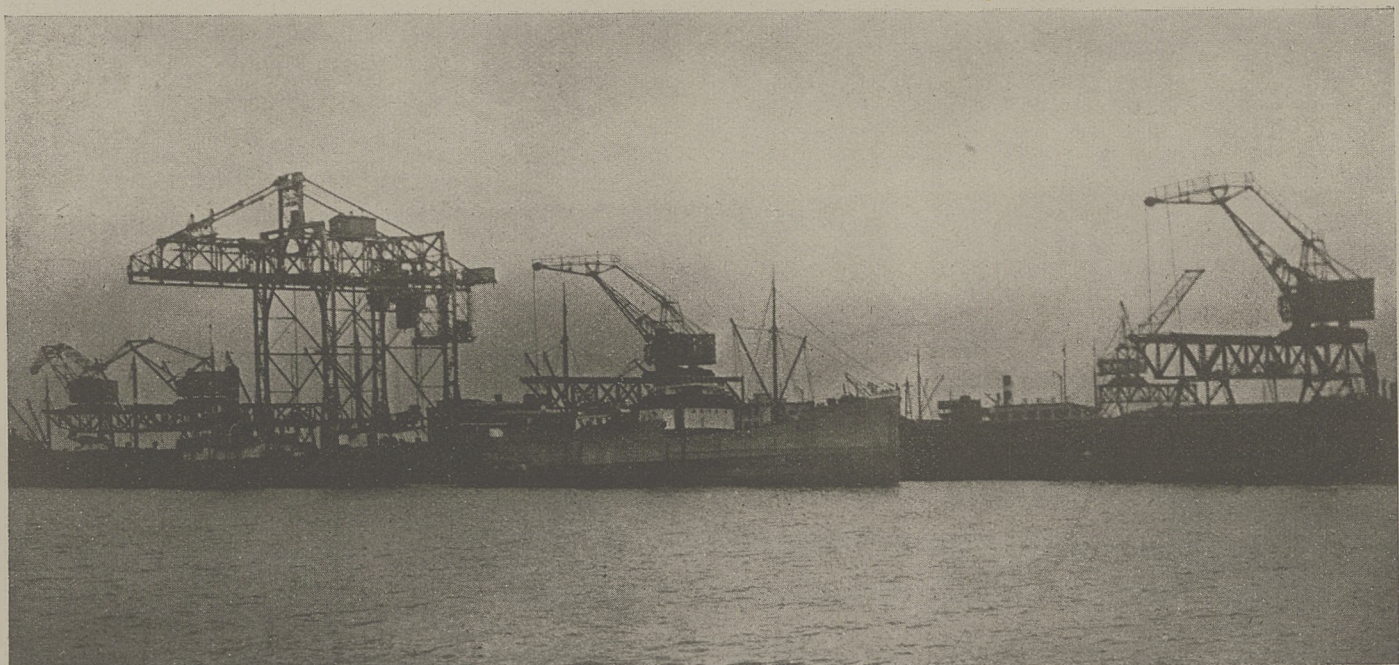
Port Gdyniński. Nabrzeże Szwedzkie. Instalacje przeladunkowe dla węgla f-my „Polskarob”. Gdynia Harbour. Swedish Wharf. Transhipment plant of the firm “Polskarob”.
