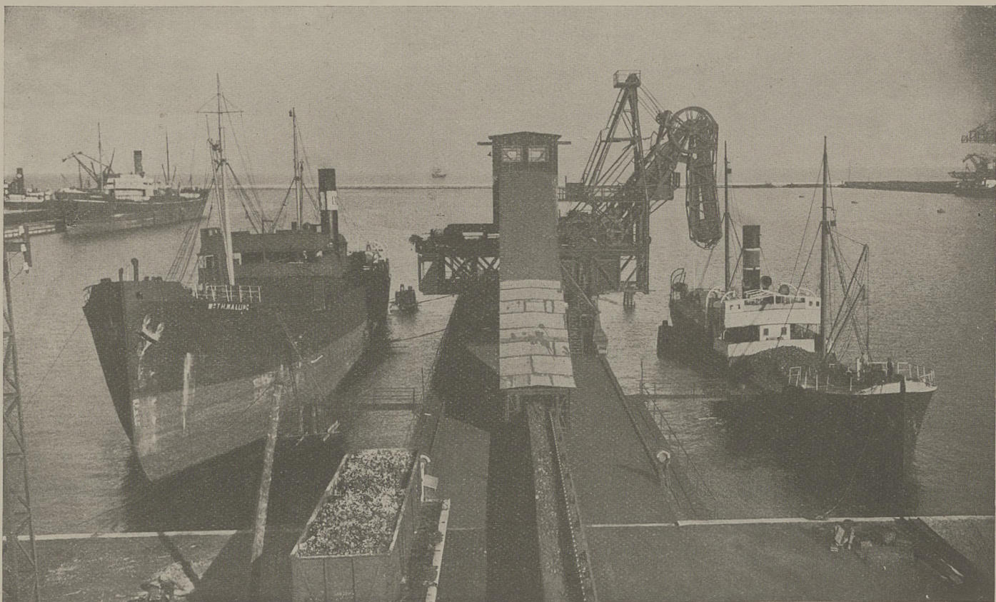
Port Gdyniński. Nabrzeże Duńskie. Instalacje przeladunkowe dla węgla f-my „Skarbopol”. Gdynia Harbour. Danish Wharf. Transshipment plant of the firm “Skarbopol”.
