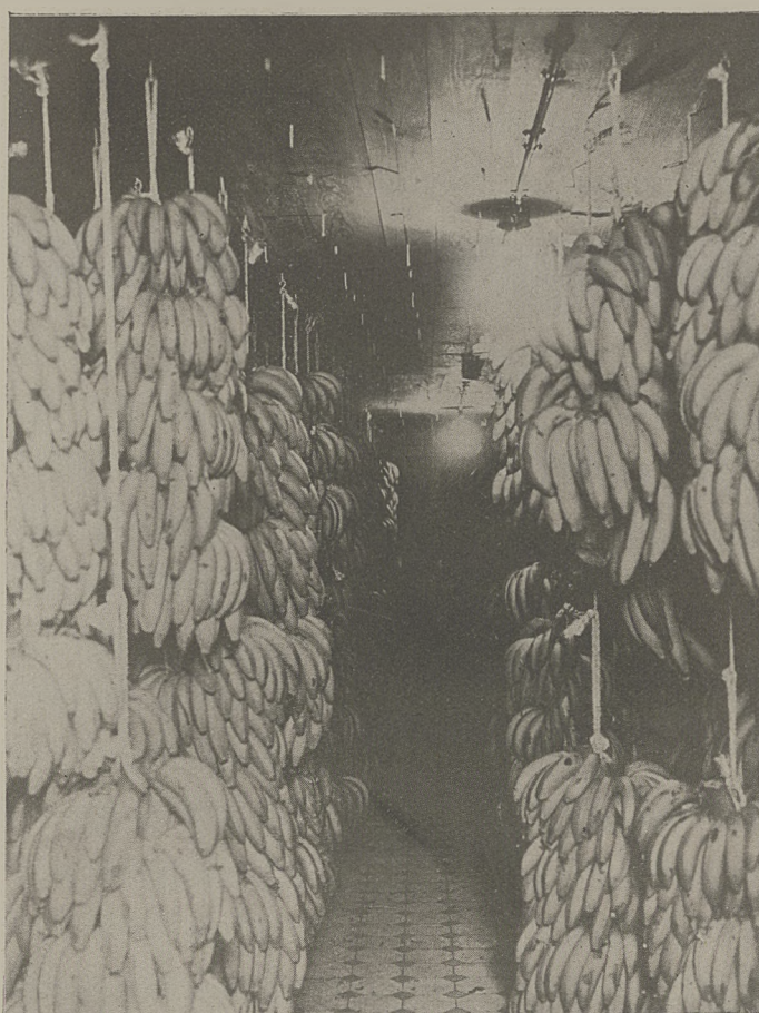
Polski Przemysł Owocowy „Bananas”. Dojrzewalnia posiada sześć komór, każda o pojemności 10—12 ton co umożliwia jednoczesne dojrzewanie około 75 ton bananów. Specjalne urządzenia umożliwiają kontrolowanie samego procesu dojrzewania t. j. regulowanie szybkości i przedłużenie lub skrócenie procesu dojrzewania
