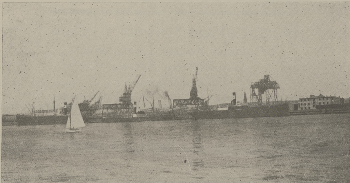
Port-Gdynia. Instalacje przeladunkowe na molo śląskiem
