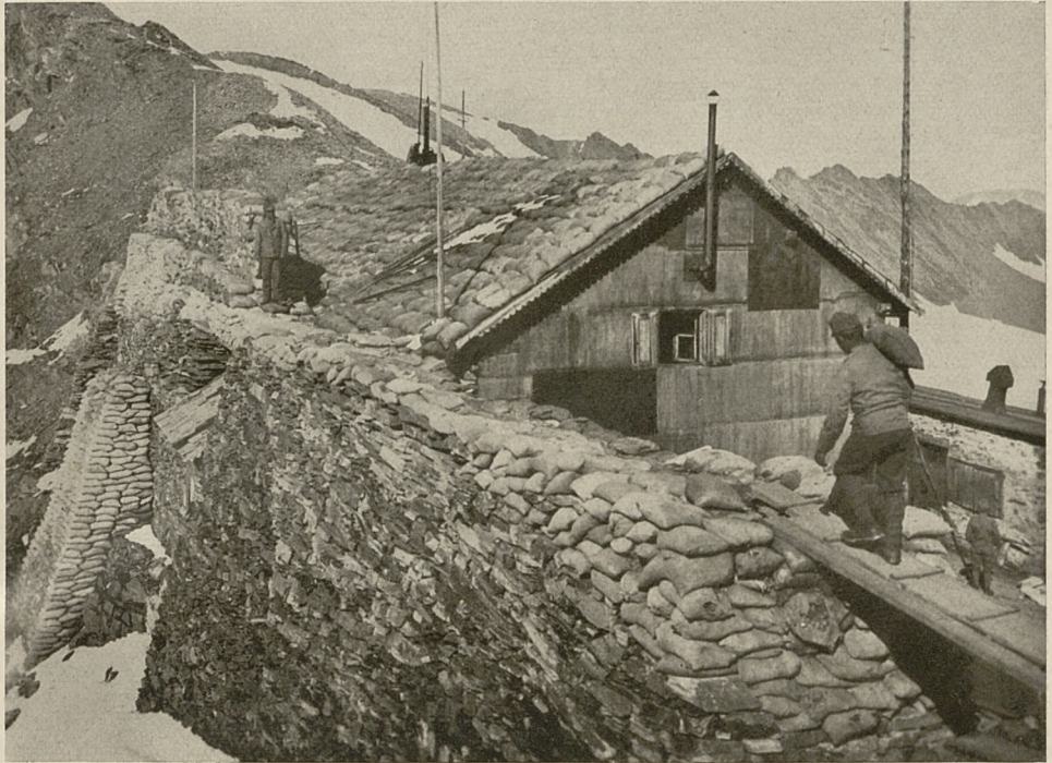
Halleische Hütte am Eisseepeß, mit Sandsack-Mauer
