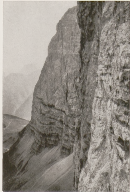
Blick vom alten Validerer-Wand-Weg gegen Osten Neigungsverhältnisse der unteren Wandhälfte (etwa 400 m Höhe) des Ostteiles der Validerer Wände. Links Hohlloch und Grubenfuge, Nordpfleiler
