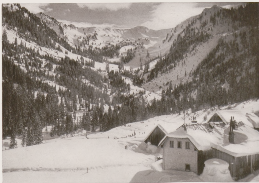
Mörsbadhütte (D. A.-B. Prag) gegen Bärneck (nach dem Umbau im Jahre 1935)
