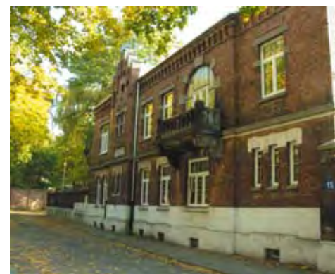
Kompleks budynków przy ul. Spokojnej 15, obecnie należący do ASP
