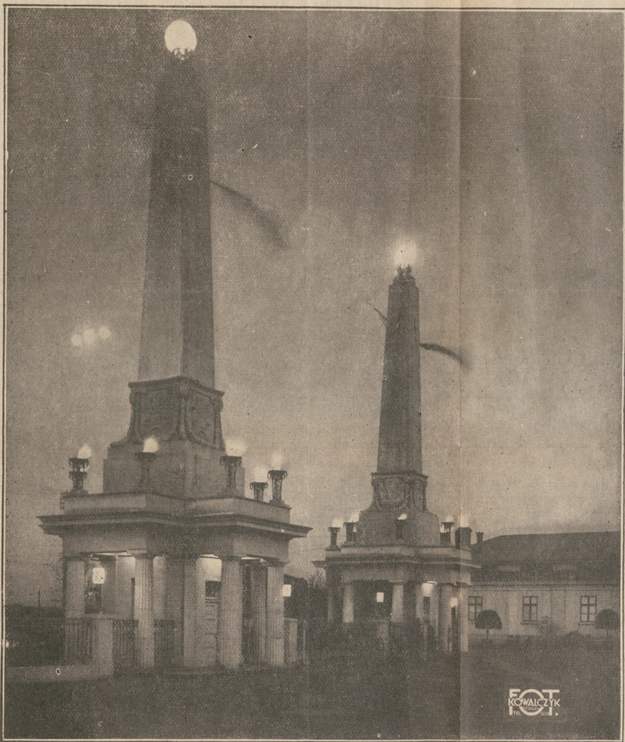
Główne wejście na P. W. K., oświetlone wspaniałymi lampami elektrycznymi.
