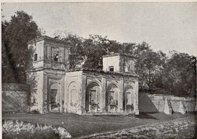
Fig. 3. Fot. cliché: K. Baudoin de Courtenay Fragment murów b. klasztoru kartuzów Un fragment des murs de l'ancien couvent des Chartreux.
