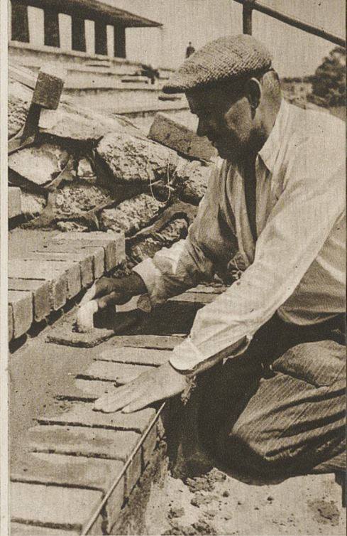
Murarz Krzyszkowski jeden z najstarszych pracowników budowy.
