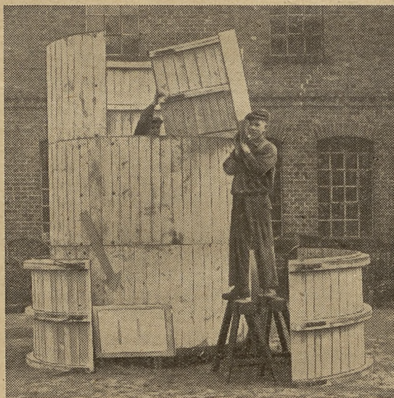
Forma do betonowania w ziemi.
