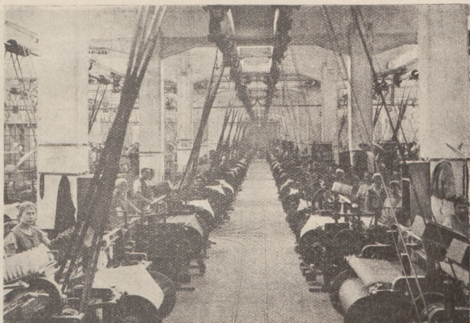
Tkálnia lniarska — Budynek parterowy z górnym światłem.
