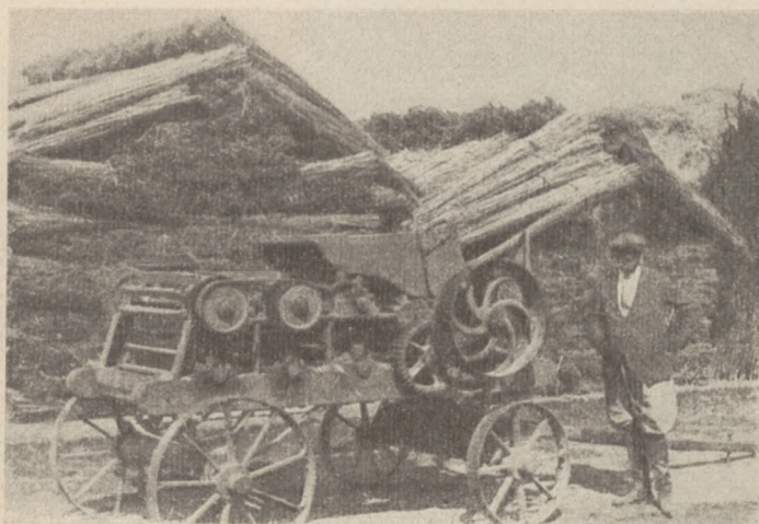
Italia. Ferrara. Miedlarka do napędu mechanicznego systemu „Ferriani” składa się z 2—3 par walców łamiących oraz 2—3 par wiatra ków wyrzucających paździerze.
