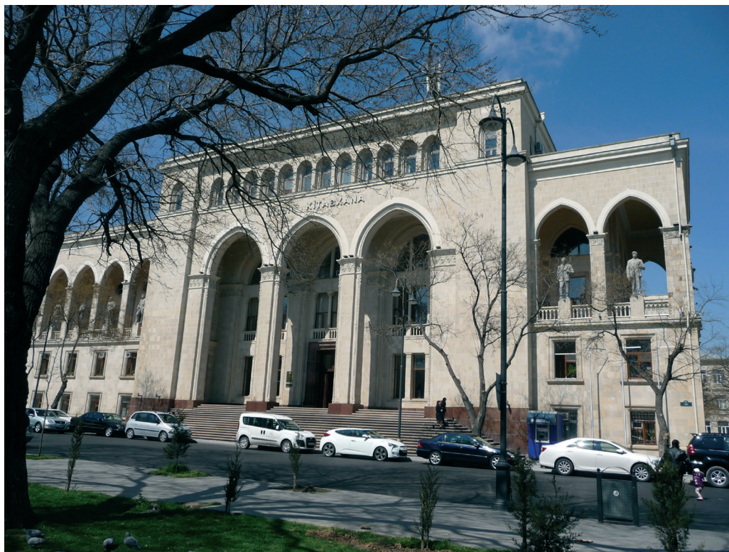
Fot. 1. Fasada głównej Azerbejdżańskiej Biblioteki Narodowej w Baku
