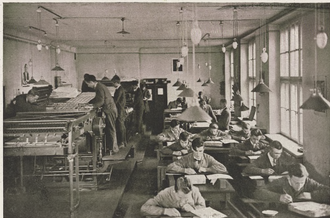
SALA MASZYN LITOGRAFICZNYCH I RYSOWNIA.
