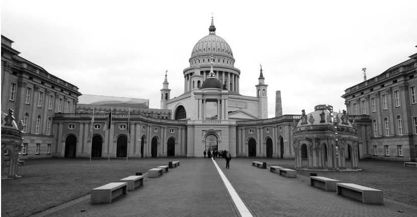
Rys. 4. Portal Fortuny widziany od strony wewnętrznego dziedzińca zamku. Fot. Ł. Skoczylas (2016)
