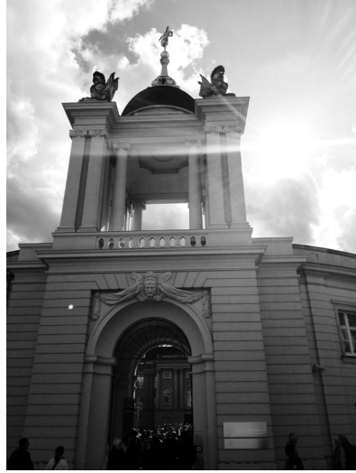
Rys. 3. Portal Fortuny – wejście główne na dziedziniec Zamku Miejskiego w Poczdamie. Fot. D. Gortych (2017)
