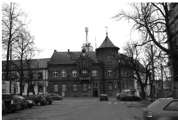
Rys. 5. Budynek sądu grodzkiego w Jordanowie widziany od strony rynku. Fot. K. Kwiatkowski
