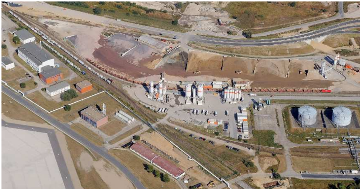
Fig. 3. Centralized Concrete Mixing Plant Rys. 3. Scentralizowana wytwórnia betonu
