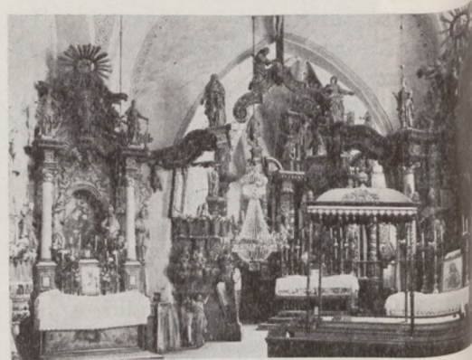
Wnętrze kościoła. Fot. T. Przypkowski (Neg. IS PAN).
