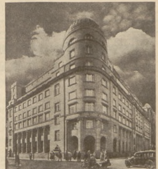
Head office P. K. O. Warsaw
