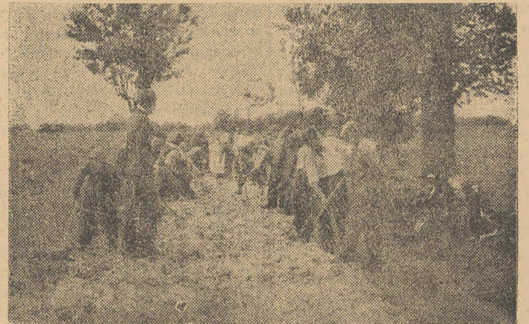
Budowa nowej drogi kolejowej w pow. inowrocławskim.
