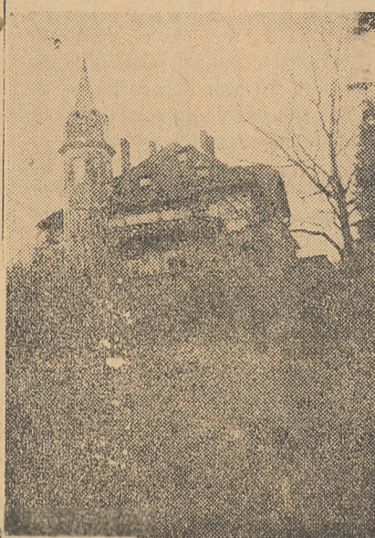
W domu ChTPD w Karczewniku k/Chodzieży mieszkają chłopskie dzieci, nie mające już rodziców.
