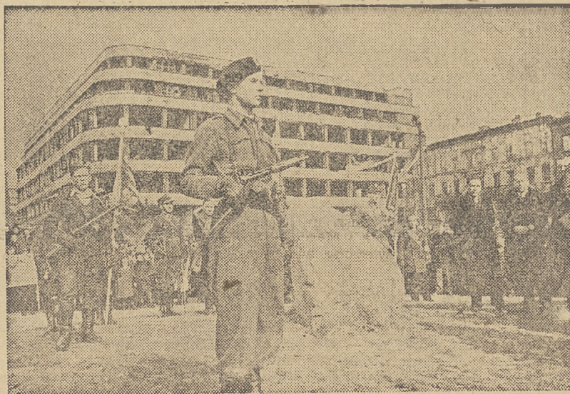
ODSLONIĘCIE KAMIENIA PAMIĄTKOWEGO
