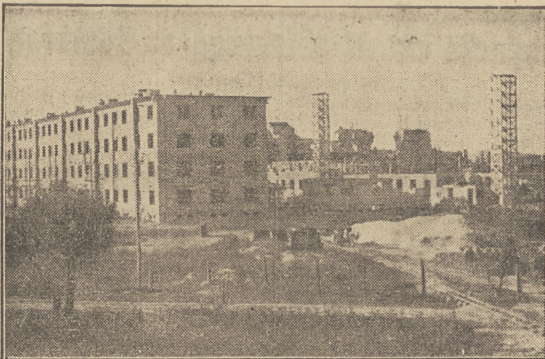
Odbudowa domów mieszkalnych jest naczelnym zagadnieniem odbudowy Stolicy. Fragment budowy nowych domów mieszkalnych na Żoliborzu
