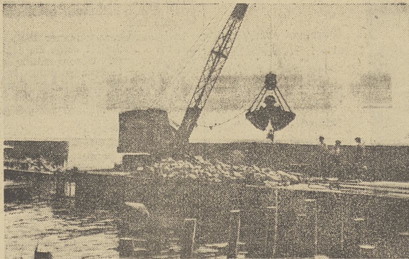
Odbudowa basenu jachtowego w Gdyni
