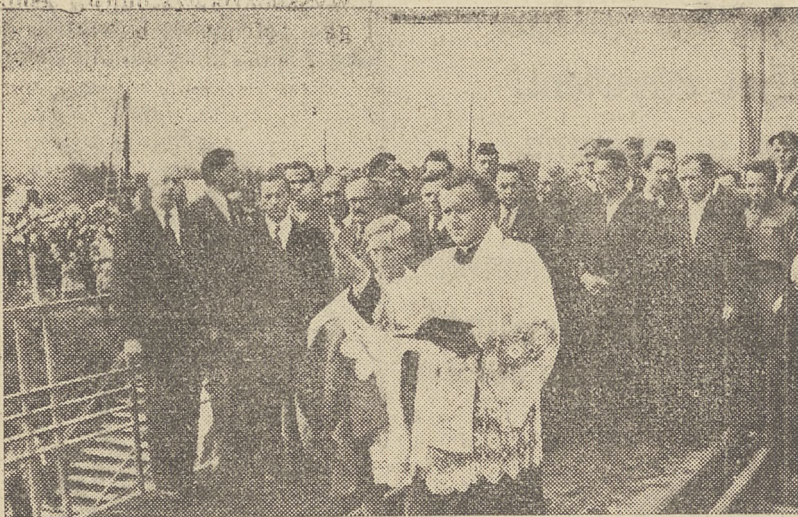
Uroczyste poświęcenie i otwarcie mostu kolejowego pod Cytadłą w Warszawie. Po lewej stronie Premier Cyrankiewicz.
