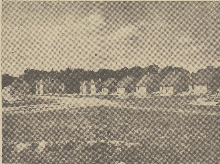
Budowa osiedla domków fińskich dla górników
