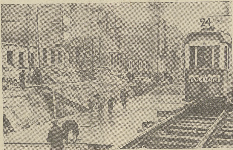
Prace przy budowie tunelu średnicowego na odcinku Alei Sikorskiego dobiegają końca. W tej chwili kończy się nakrywanie płyt betonowych.
