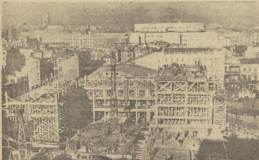
Budowa gmachów Min. Przemysłu przy Placu Trzech Krzyży postępuje szybkie naprzód. Już dziś mury gmachów przerastają sąsiednie domy.
