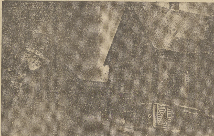
Tak wygląda dom mieszkalny Łabudów
