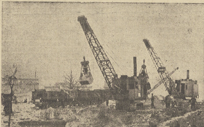
Z odbudowy Stolicy — parowe kopaczki przy pracy na trasie W — Z.
