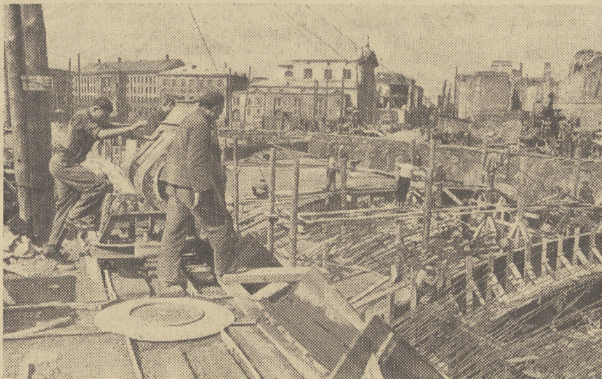
Tempo amerykańskie jest za słabym określeniem budowy trasy W—Z. Na wiosnę były tu tylko ruiny. Dziś betonuje się pierwsze stropy tuneli
