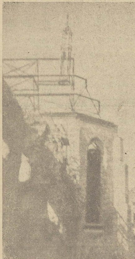
Katedra św. Jana ma już konstrukcję dachową.
