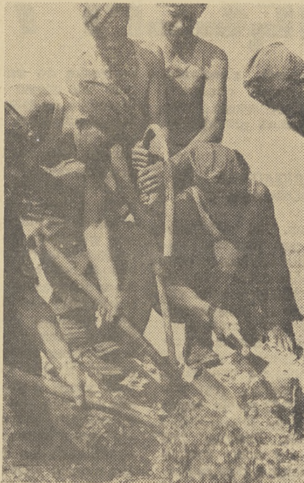
Wykonała liczne prace melioracyjne, zakładała rury przewodowe.
