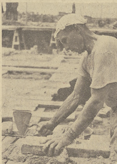
24 ubm. w Warszawie murarz Religa z dwoma pomocnikami ułożył mur z 10.602 cegieł. Rekord jego pobili Franaszczak.
