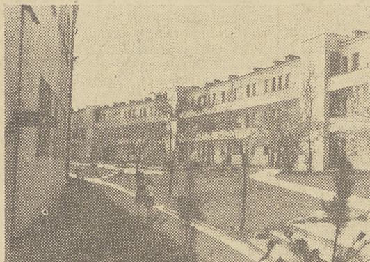
Odbudowane kolonie Warszawskiej Spółdzielni Mieszkaniowej są wzorem dla nowobudowanych. Tak wyglądać będą wszystkie kolonie.
