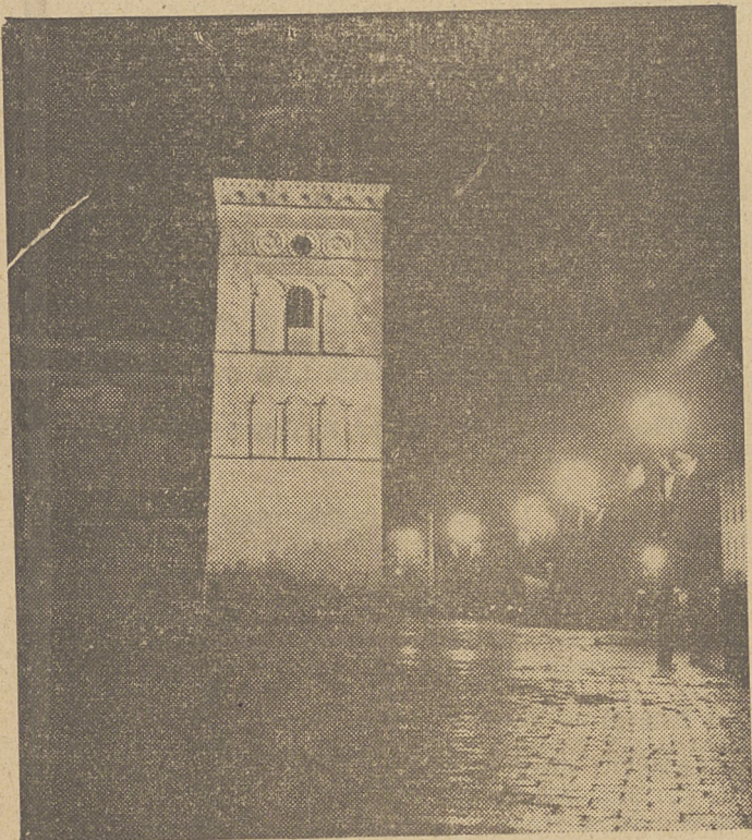
Zabawkowa dawonnica kościoła św. Anny pięknie wygląda w blasku reflektorów. Wraz z kościołem wydaje się obecnie znacznie podwyższona, dzięki obniżeniu wiaduktu, który prowadził do mostu Śląskiego
