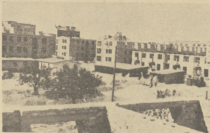
W takich to domach mieszkać będziemy w Warszawie. Widok ogólny budowanych obecnie bloków na Mokotowie.
