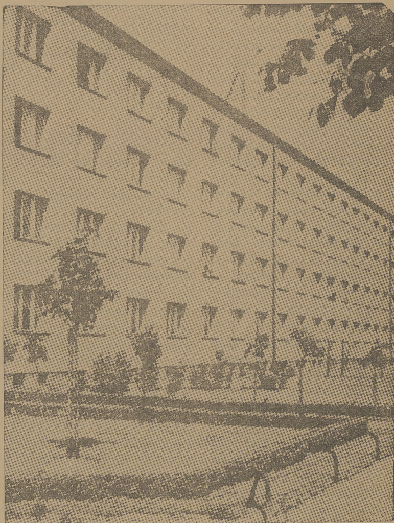
Zamiast dawnych brzydkich kamienic — nowoczesne kolonie mieszkaniowe wybudowano przed wojną dla pracowników na przedmieściach Warszawy, gdzie obecnie te domy zamieniają się w ruiny w walkach z Niemcami.
