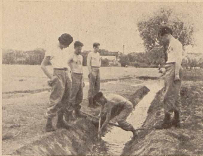
Les travaux de melioration.
