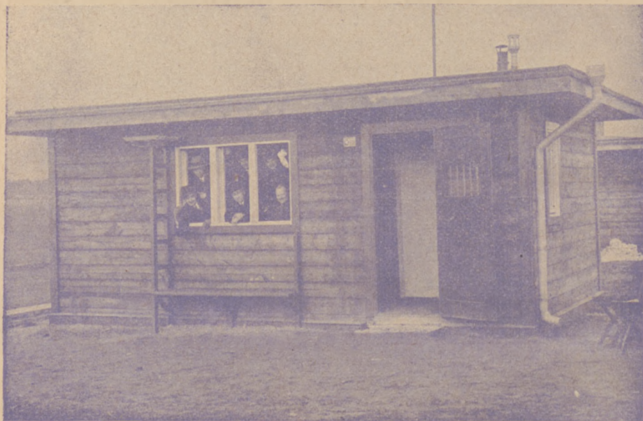
Jeden z domków mieszkalnych.
