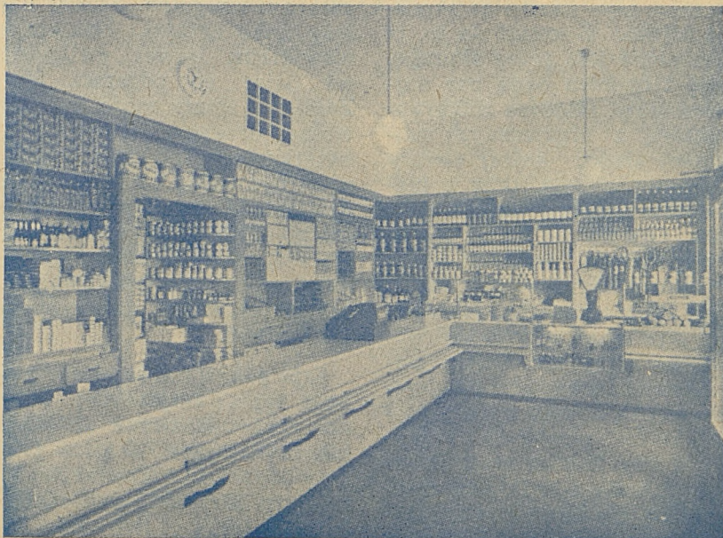
Sklep do przebudowie
