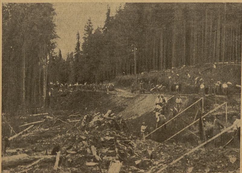
Junacy przy budowie drogi w Karpatach Wschodnich.
