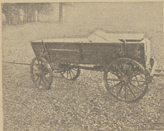
Wodoszczelny wóz do przewożenia ryb.
