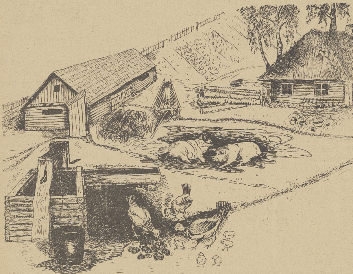
Studnia, wybudowana w gospodarstwie w nieodpowiednim miejscu, do której dochodzą ścieki, do której inwentarz ma dostęp swobodny, daje wodę brudną, roznosi zarazki chorób.
