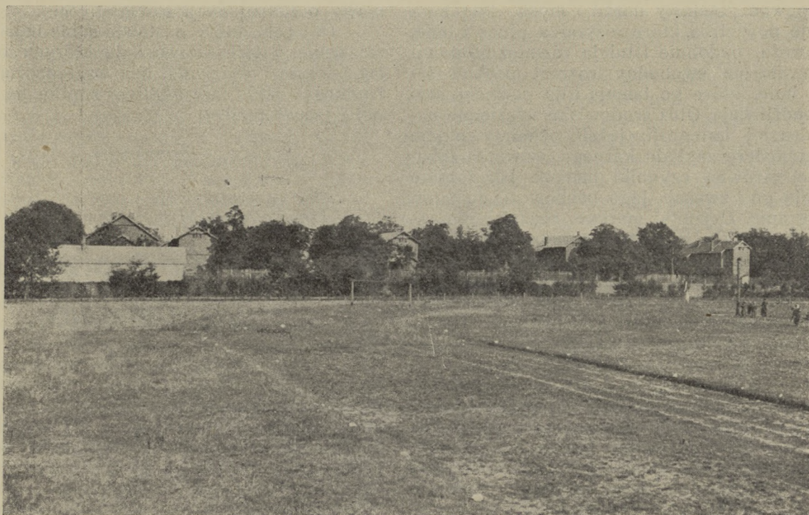
Widok ogólny Zakładu w Studzieńcu.
