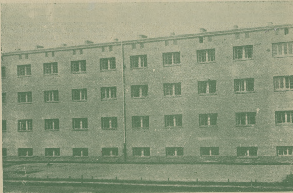
Nowowbudowany pawilon więzienia w Wejherowie.
