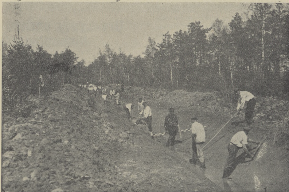
Budowa kanału w Achja.
